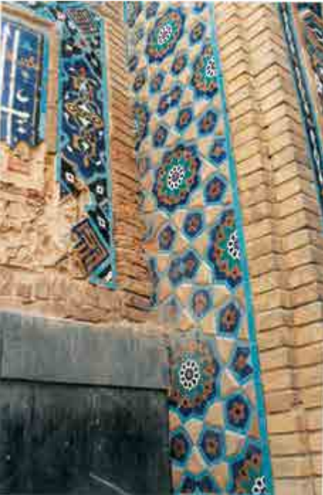
تصویر ۷. محل الحاق منازل سمت چپ به بنا که بخشی از کاشی‌ها را می‌پوشاند. تصویر از نگارنده
